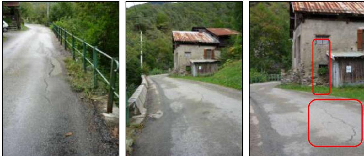
Figure 2 : Fissures sur la route (se prolongeant sur les constructions, à droite) en bordure du ruisseau de Hauteville [Source : IMS<sub>RN</sub>]
