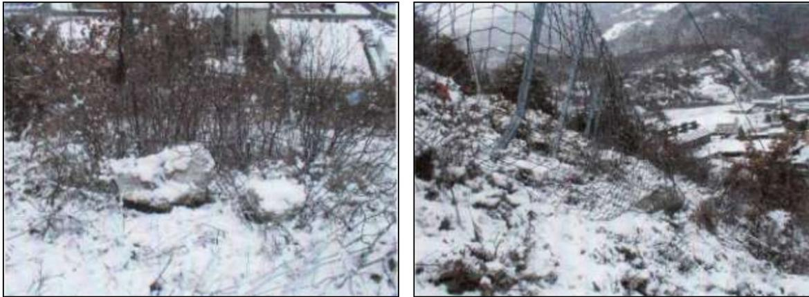
**Figure 9 :** Blocs arrêtés par les filets en janvier 2005 [Source : rapport RTM du 21/01/2005]
