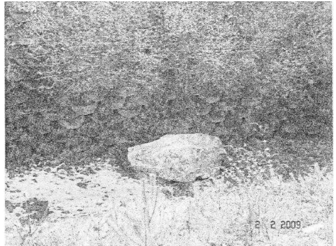
**Figure 12 :** Bloc arrêté par le merlon (2 x 1,5 x 0,8 m) [Source : rapport RTM du 30/01/2009]
