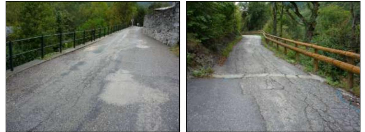
Figure 5 : Fissuration et affaissement de la route à l'Ouest du village [Source : IMS<sub>RN</sub>]
