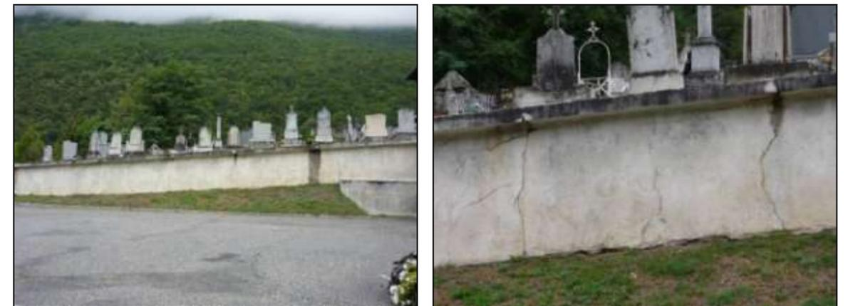
Figure 6 : Fissuration du mur du cimetière du fait du déplacement des terrains vers l'aval [Source : IMS<sub>RN</sub>]
