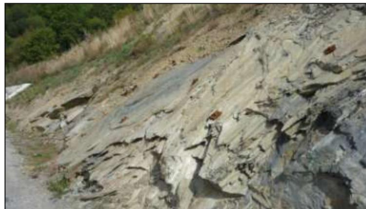
Figure 2 : Ancrages dans les schistes houillers [Source : IMS<sub>RN</sub>]
