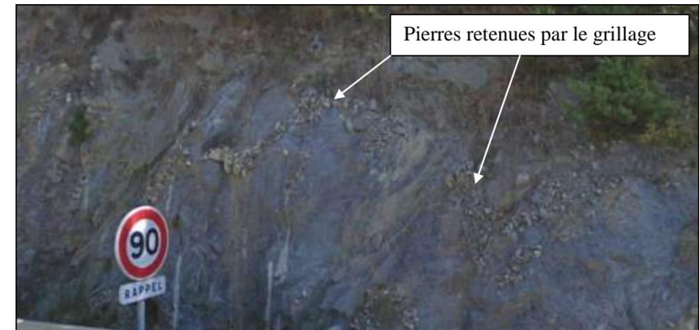
Figure 15 : Grillage efficace contre la chute de pierres [Source : IMS<sub>RN</sub>]
