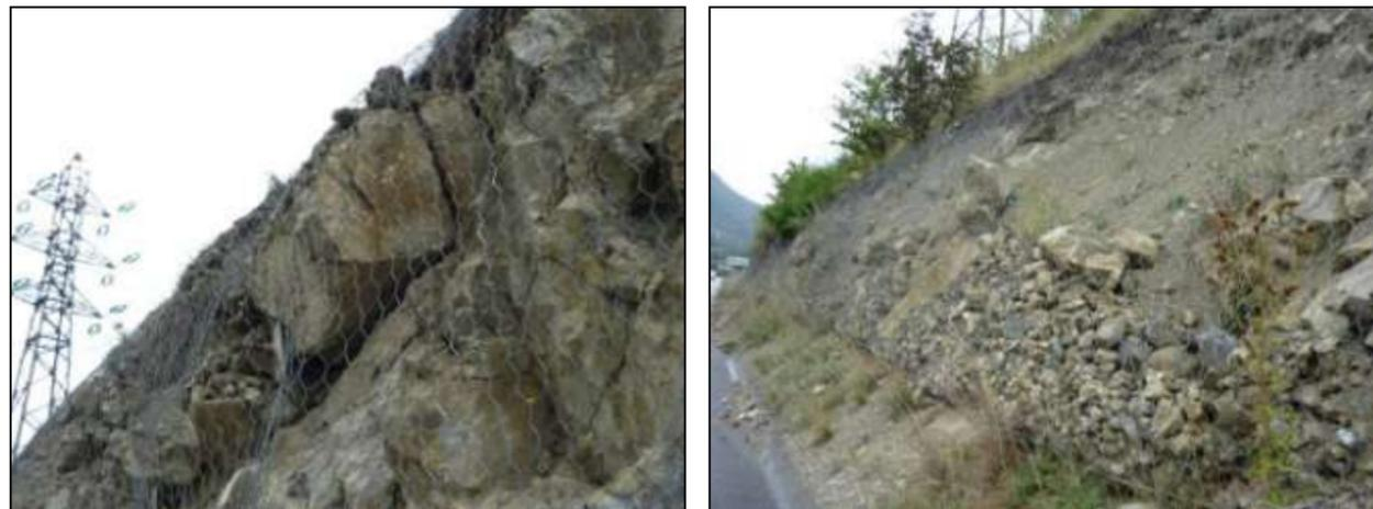
Figure 1 : Bloc instable (à gauche) et grillage chargé en pierres et blocs (à droite) [Source : IMS<sub>RN</sub>]
