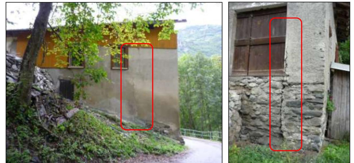
Figure 1 : Fissures sur des constructions en bordure du ruisseau de Hauteville [Source : IMS<sub>RN</sub>]
