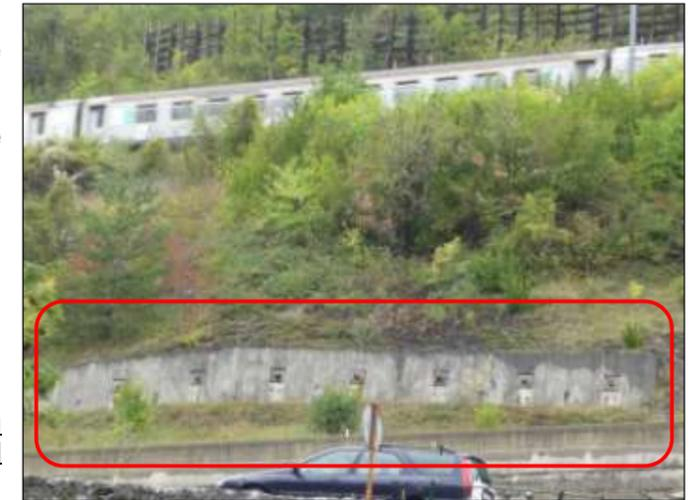
Figure 2 : Mur de confortement sous la voie ferrée au niveau de Pomblière [Source : IMS<sub>RN</sub>]
